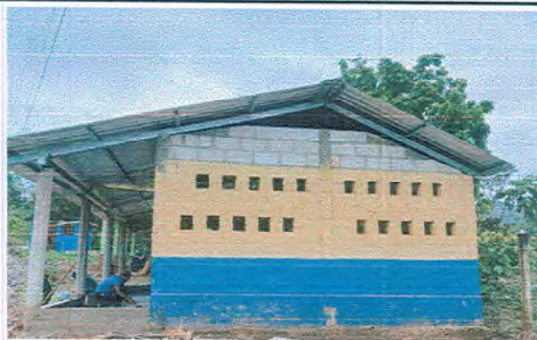
Foto 2: Levantamiento de 3 hileras de block Módulo III.
