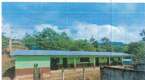
Foto 5: Módulo I finalizado.
