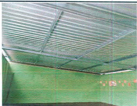
Foto 3: Interior aula Módulo I.
